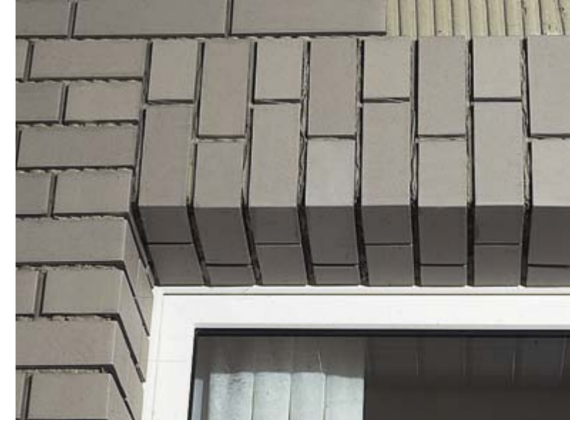
Ein mit Winkelriemchen und geschnittenen Flächenriemchen perfekt nachgebildeter Sturz.
