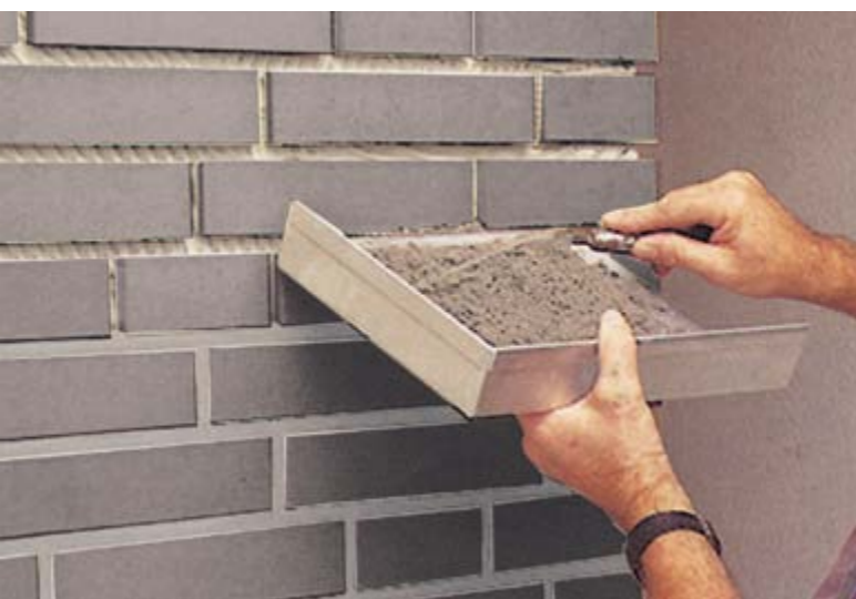
Die Alternative: Sauberes Verfugen mit Fugeisen und Fugblech.
