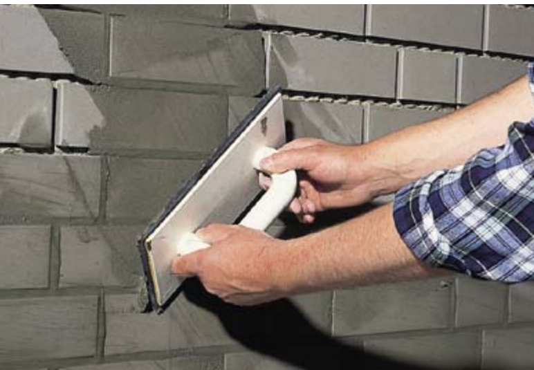
Im Schlämm-Verfahren werden die Fugen diagonal mit einem Putzbrett verfüllt.
