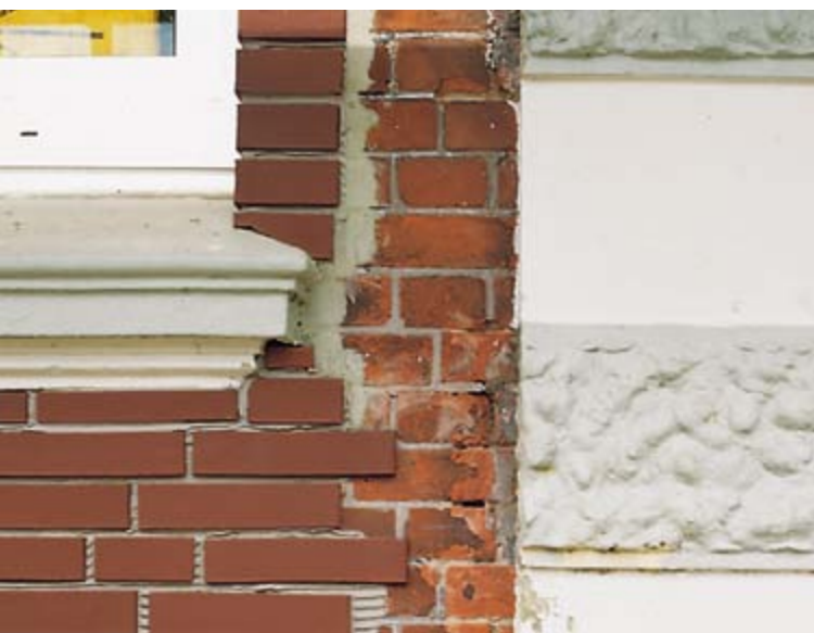
Stück für Stück verschwindet das alte, beschädigte Mauerwerk hinter der neuen Riemchenfläche.
