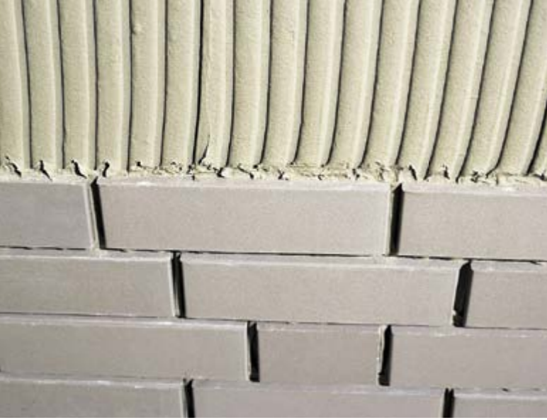
Die Riemchen sind vollständig in den Kleber eingebettet.
