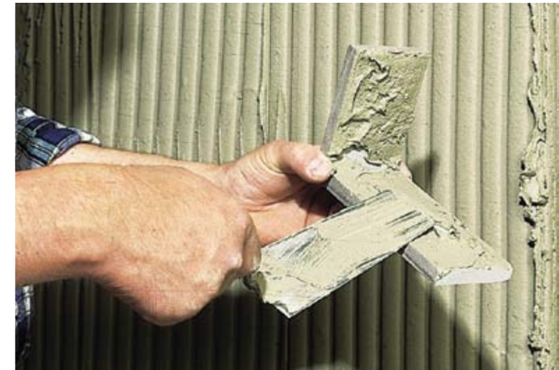
Klebeauftrag im „Floating-Buttering-Verfahren“ für Winkelriemchen
