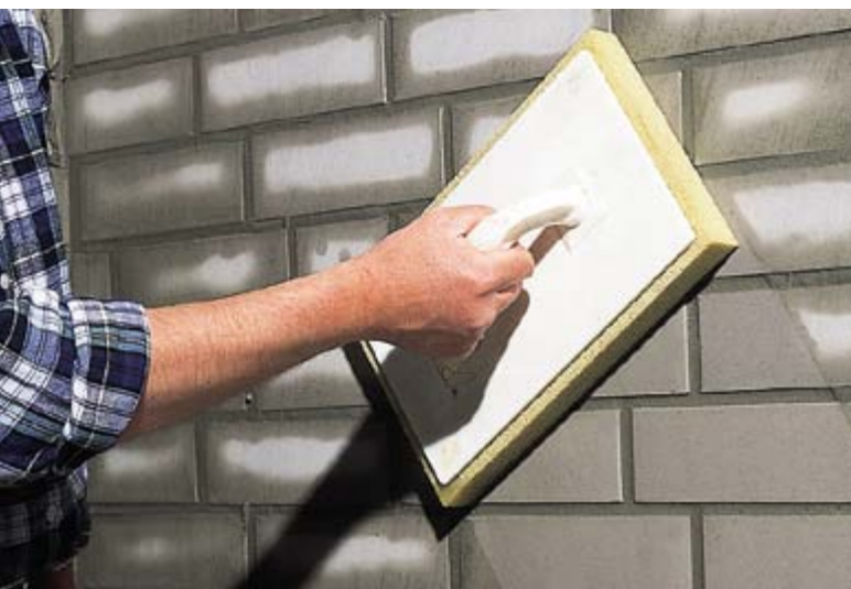
Der überschüssige Mörtel wird diagonal mit einem Putzbrett mit Schaumstoffauflage sauber abgewaschen.
