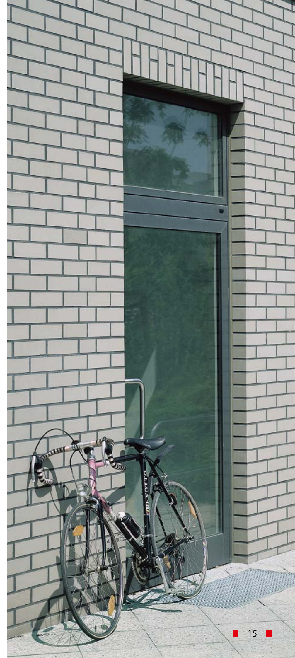
Eine mit Klinker-Riemchen ausgeführte Ziegel-Fassade. Sieht nicht nur gut aus, solange sie neu ist, sondern bleibt auf Dauer auch so. Da kann man schon mal ein Fahrrad anlehnen, ohne gleich Beschädigungen der Wand befürchten zu müssen. Bei Putz wäre das vielleicht etwas anders.
