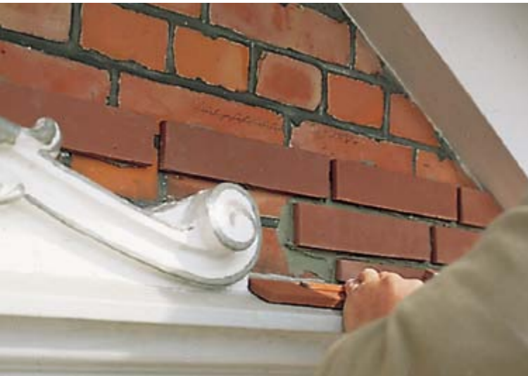
Sorgfältig werden die Klinker-Riemchen den geschwungenen Linien der Stuckelemente angepasst.
