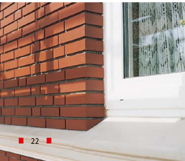
Fast fertig, es muß nur noch verfugt werden. Gut zu sehen ist die perfekte Fensterlaibung aus Winkelriemchen.
